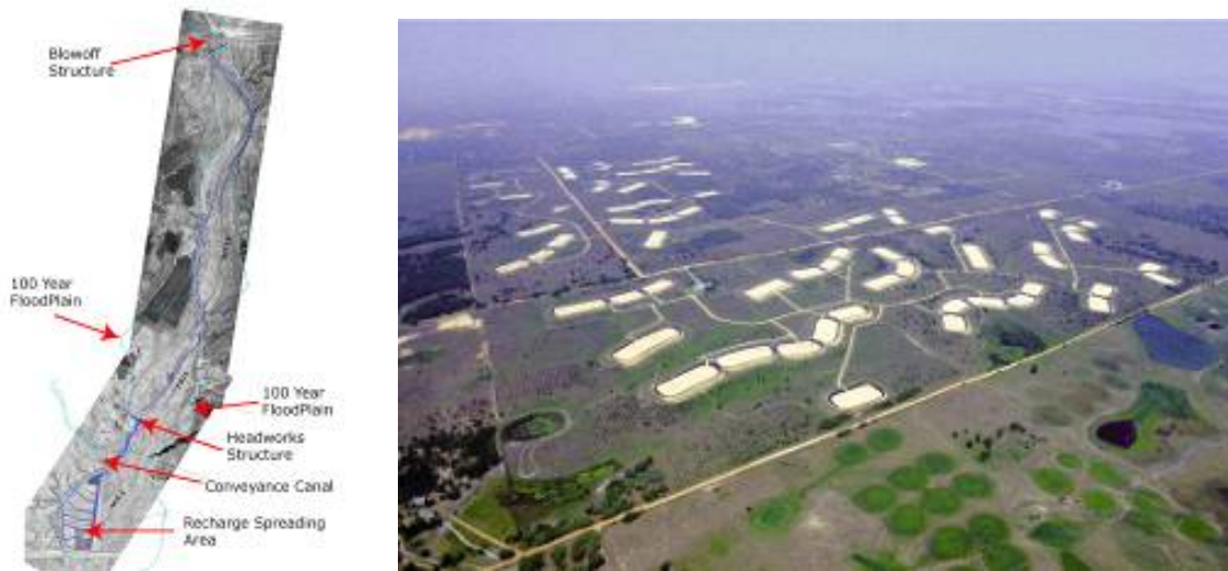
Bacini di dispersione (i) Agua Fria, Arizona e (ii) Orlando, Florida
